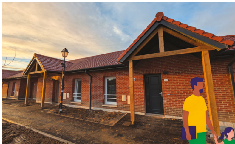
• Lauwin-Planque • Béguinage de 30 logements individuels
