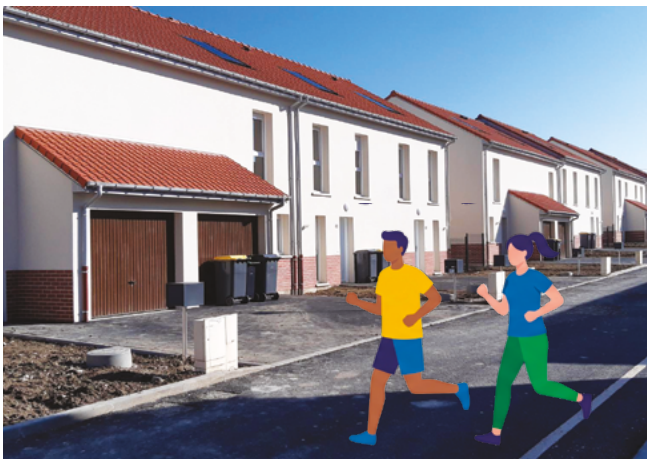
• Marquion • 45 logements individuels
