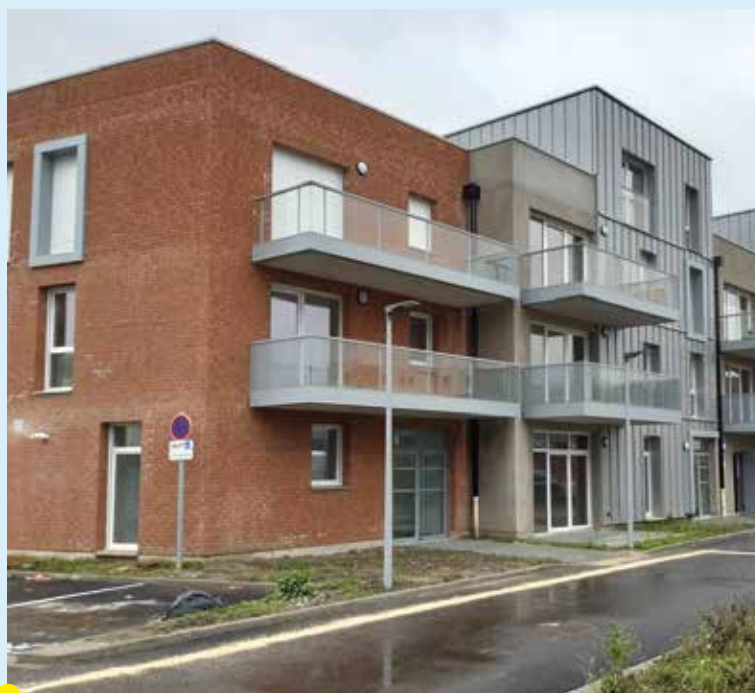
Béguinage Ginkgo à Orchies 29 logements collectifs rue Gaston Leroy.
