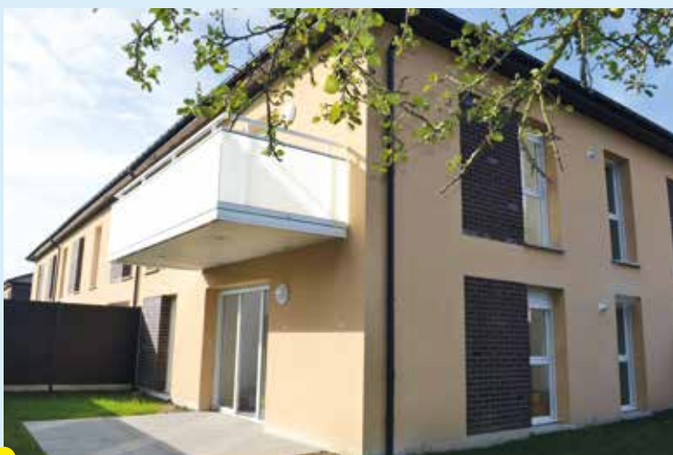
Résidence le lotissement du moulin à Râches 14 logements collectifs et 6 individuels rue du Torjo.
