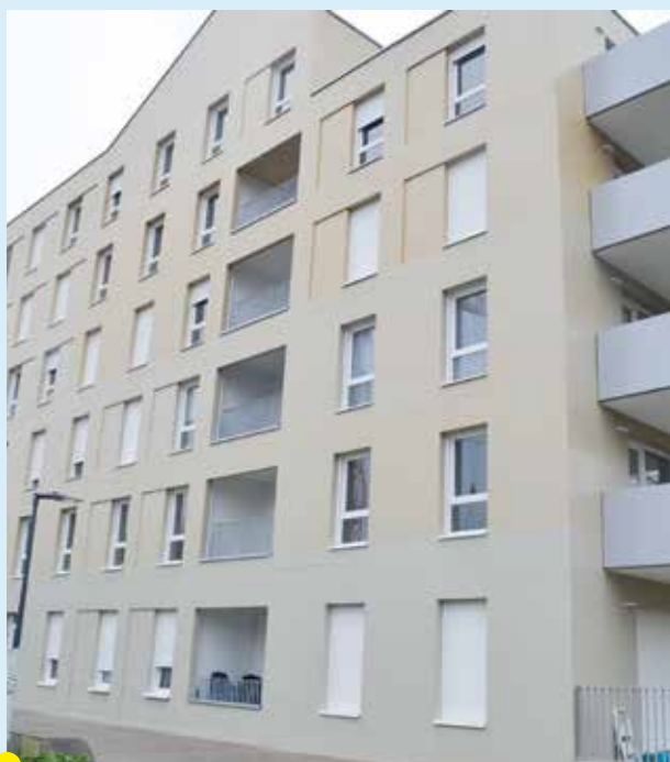
Béguinage Le Sergé à Villeneuve d'Ascq 42 logements collectifs à La Maillerie.
