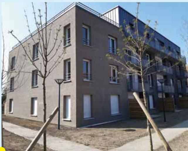
Résidence Le Jardin des Nuances à Wattignies 11 logements collectifs rue du Petit Bois.
