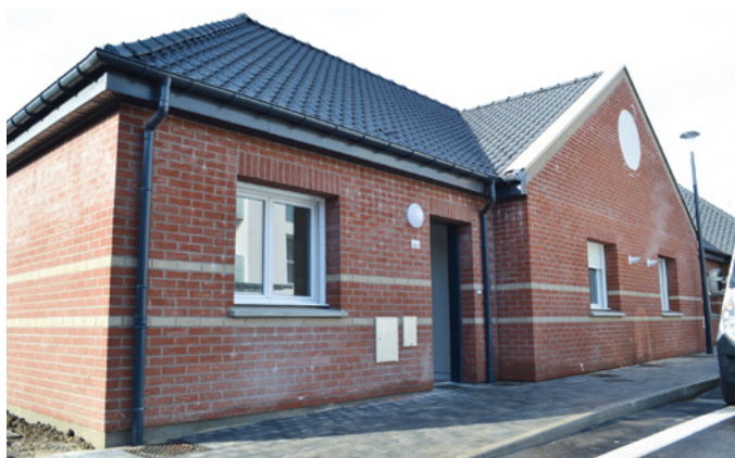
Béguinage Les Rosiers à Hénin-Beaumont : 19 logements individuels et 15 logements collectifs
