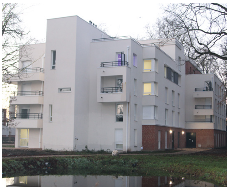
Loos - Résidence PMR (Personnes à Mobilité Réduite).
