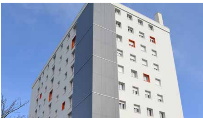
Résidence les Treize, à Cuincy, dont le chantier a démarré en 2015.
